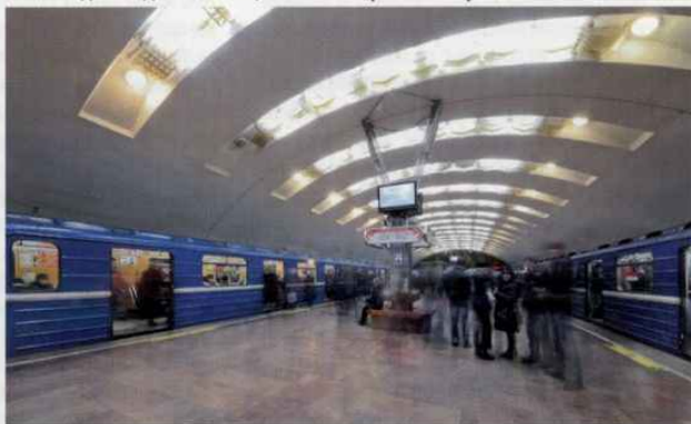
Рис. 3. Односводчатая станция Новосибирского метрополитена
