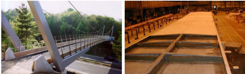
Рисунок 1.1 – Общий вид моста Halgavor (слева) и конструкция его ортотропной плиты (справа)
