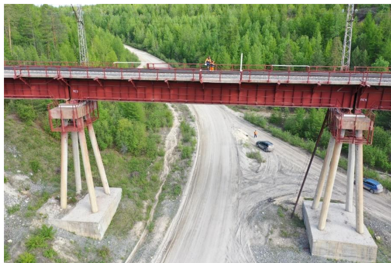
Рисунок 4.18 – Вид пролетного строения
