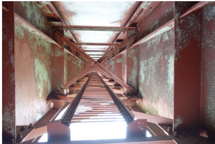
Рисунок 4.19 – Вид пролетного строения между главными балками
