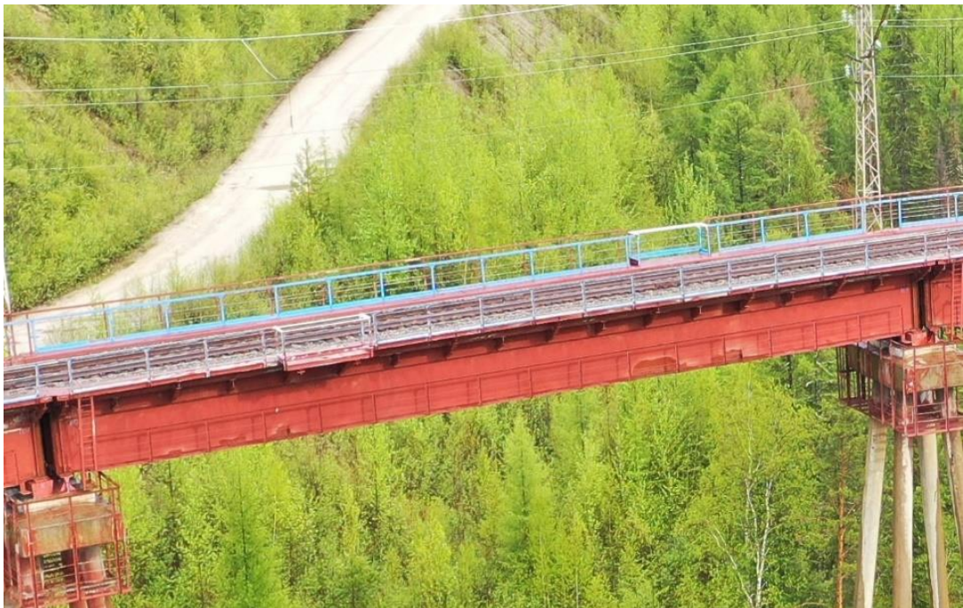
Рисунок 4.4 – Вид пролетного строения
