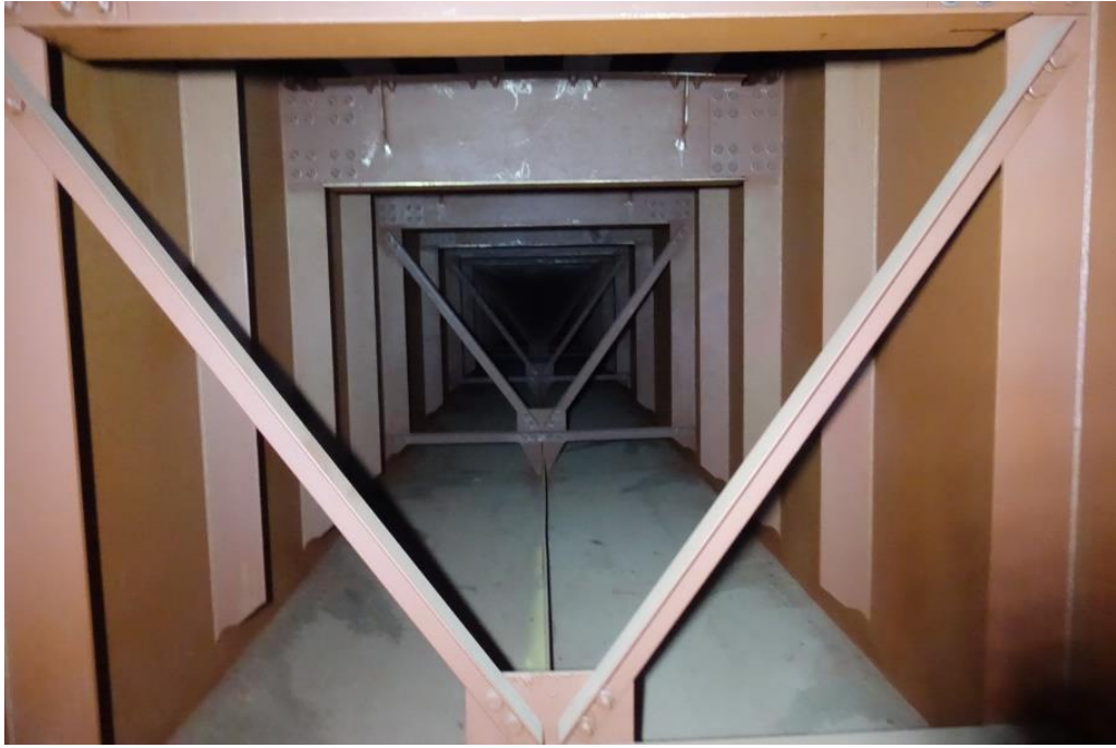
Рисунок 4.5 – Вид пролетного строения внутри коробки
