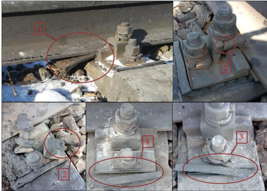
Рисунок 2.11 – Результаты натурных осмотров состояния промежуточных рельсовых креплений КБ-65: 1 – смещение регулировочных прокладок; 2 – излом клеммы; 3 – износ прокладок под подкладкой У крепления ЖБР-Ш проявились две основные проблемы (рисунок 2.12).
