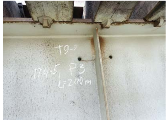
Рисунок 1 – Динамика роста и общий вид усталостных трещин:
