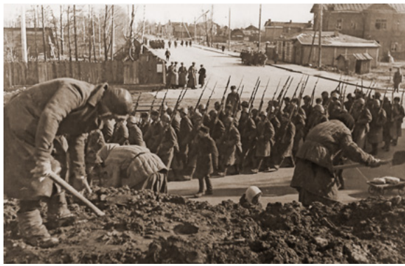
Строительство оборонительных сооружений
